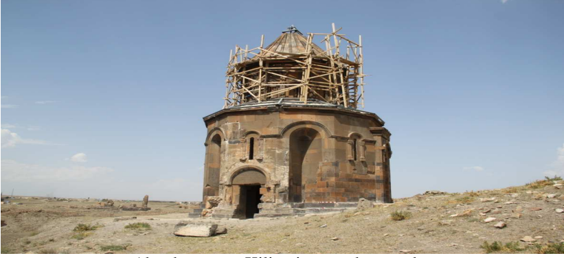
Abughamrents Kilisesi, güneybatı cephe
