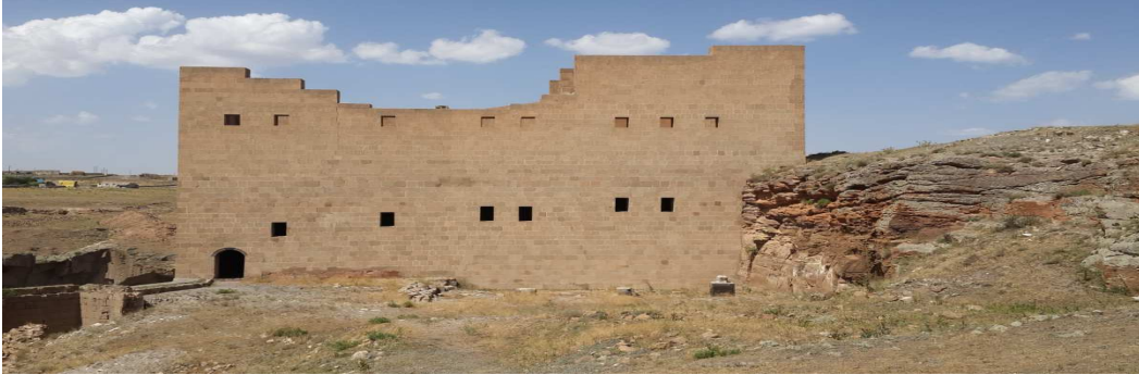
Güney cephe, bodrum katına giriş
