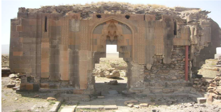
Gavit, doğu cephe
