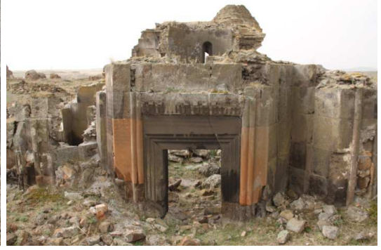
Kuzey cephedeki kapı açıklığı
