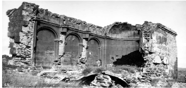
Gürcü Kilisesi, güneybatıdan (Karapetian, 2011)
