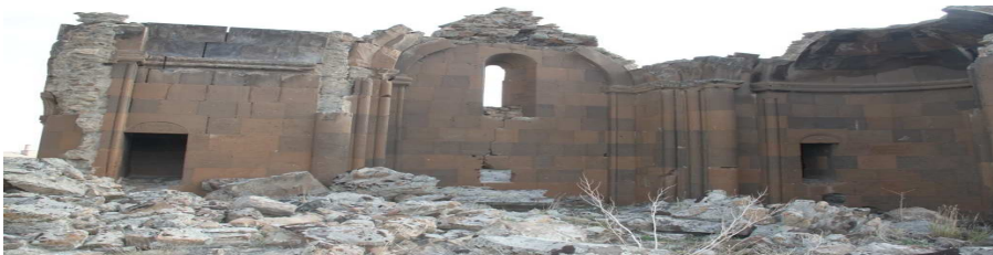
Kuzey duvar ve apsis
